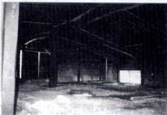
右はその内部 (二階部分)
